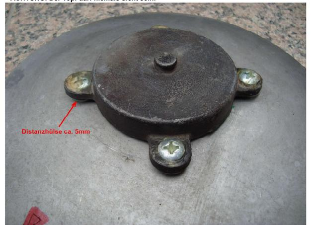
Der Topfdeckel wurde in der Mitte aufgebohrt (ca. 20mm) und mit einem Tankdeckelverschluss mit ca. 5mm Abstand zum Topfdeckel abgedeckt
